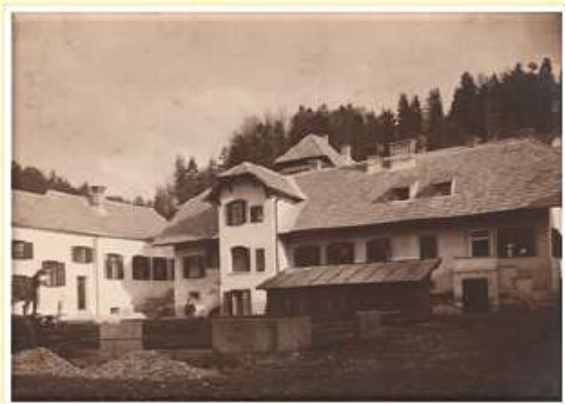
Stavba strojne delavnice leta 1959.
