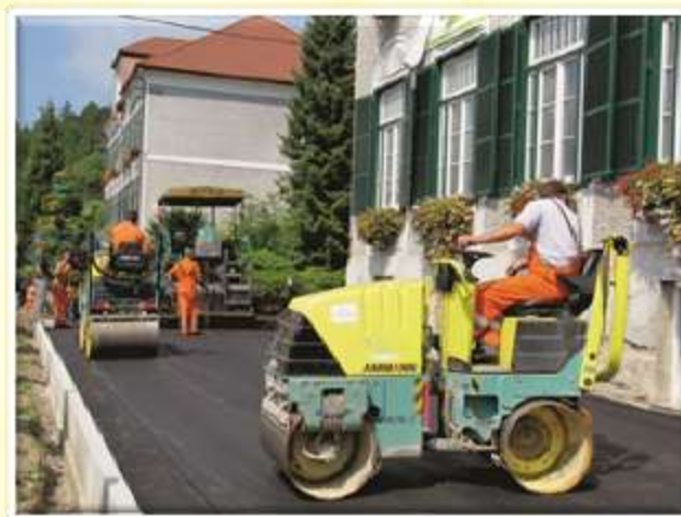
Preplastitev asfalta pred šolo, 2010.
